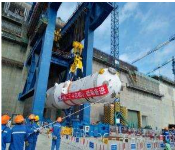
华龙一号蒸汽发生器（SG），外形尺寸:21115×4484×3440mm，设备重量:345T
