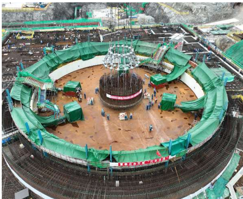
堆坑底板混凝土模块 (华龙机组首次应用)
