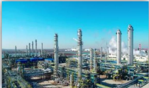
有序推进江苏徐圩供热厂
