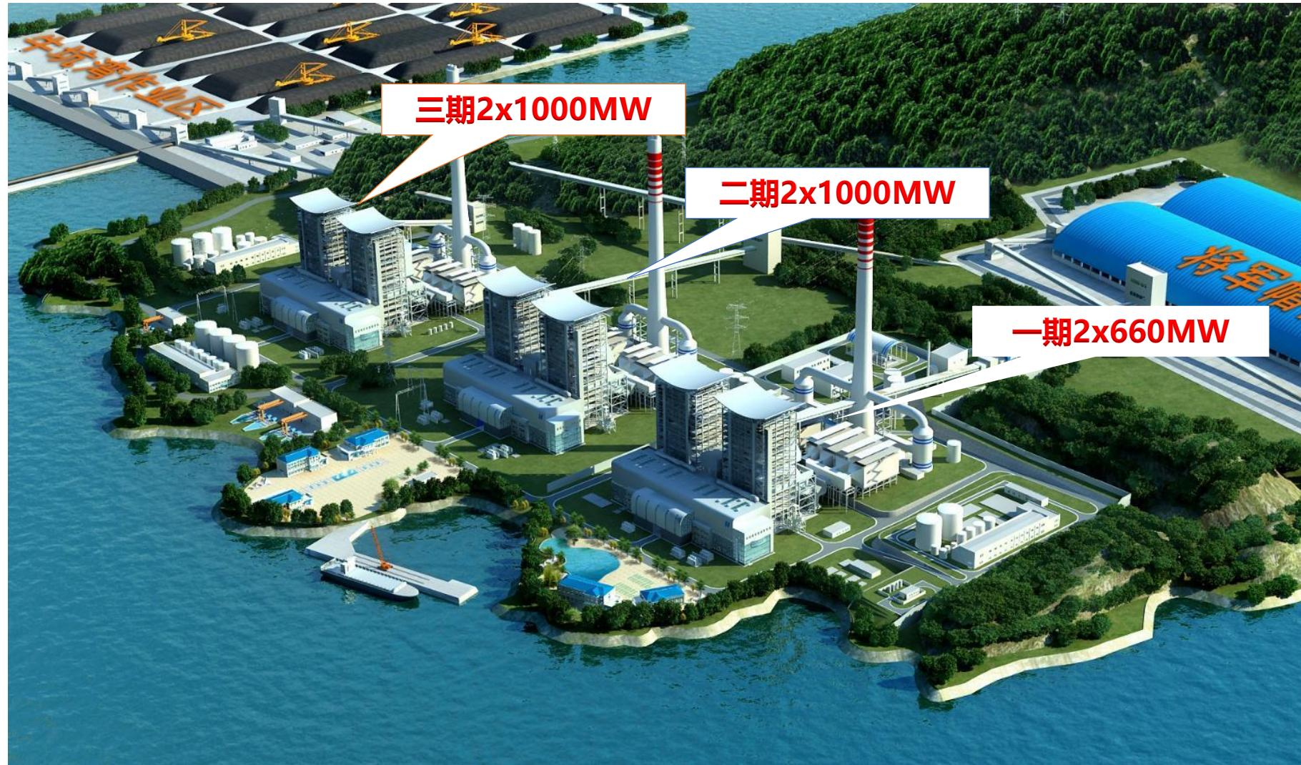
规划2×660MW+4×1000MW，一期建设2×660MW高效超超临界燃煤发电机组
