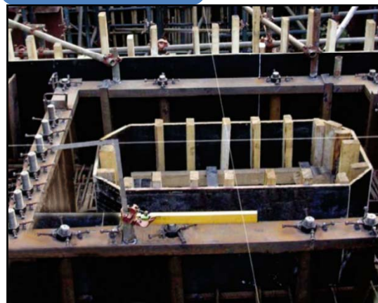
螺栓固定钢架定位工艺
