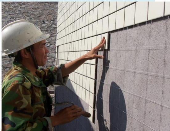
外墙饰面砖双挂线施工
