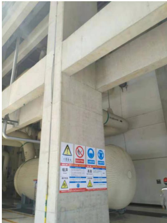
框架柱清水混凝土工艺
