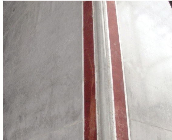
柱角预埋件施工工艺
