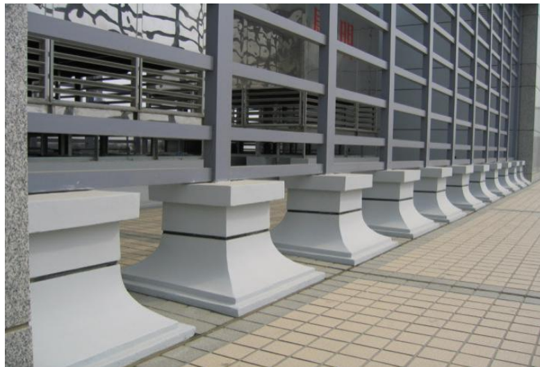
屋面构筑物与屋面分隔缝布置统筹规划
