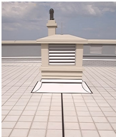
出屋面构筑物交接面圆弧处理
