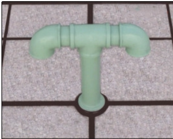
屋面排气孔施工工艺
