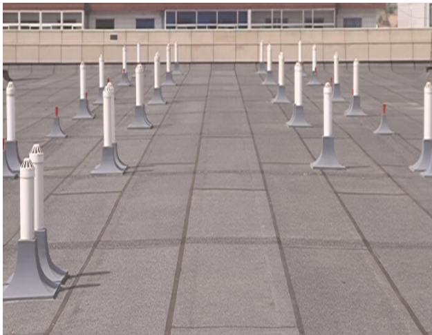
卷材防水、基层排气管道施工工艺
