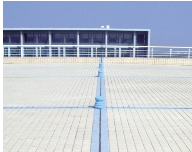
屋面排气管根部打胶结合分隔缝统一考虑
