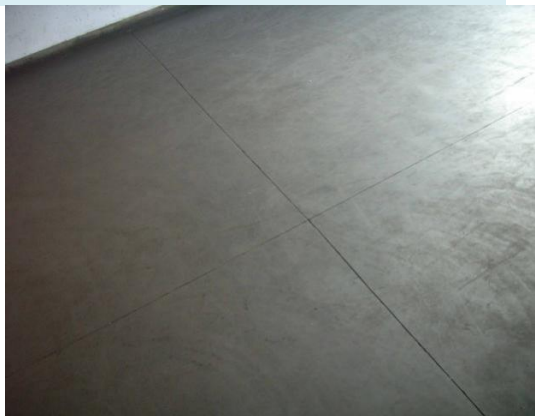
室内混凝土耐磨地面分隔缝
