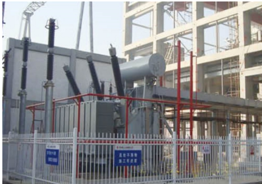
主变隔离围栏工艺
