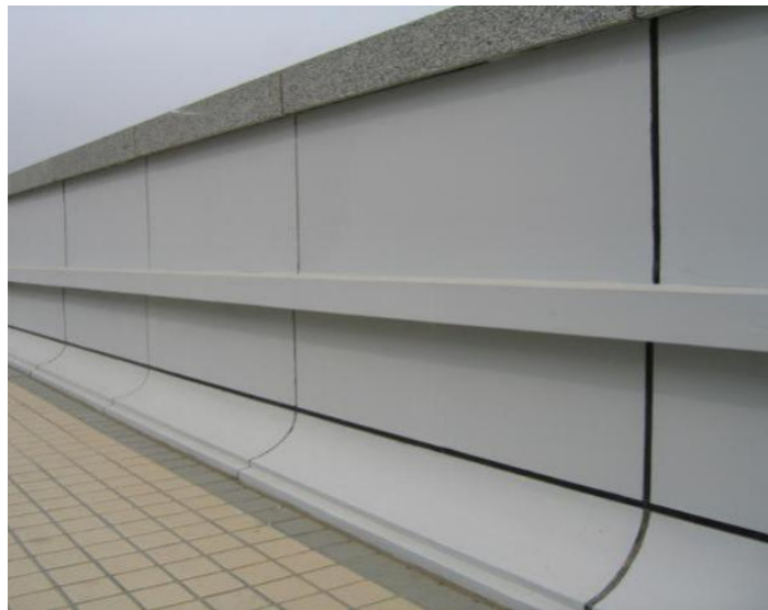
女儿墙内侧分隔缝布置及滴水工艺 8
