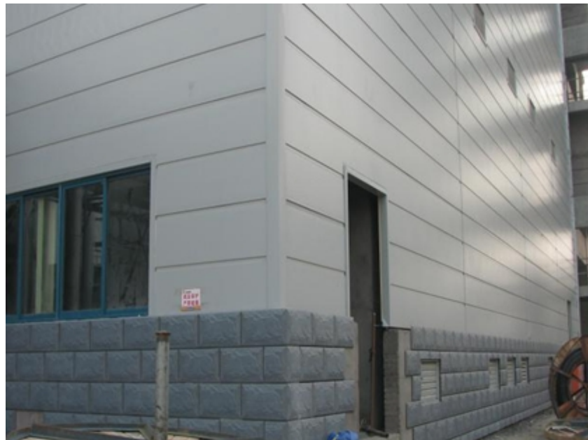
下部仿蘑菇石勒脚、上部复合夹芯板外墙封闭工艺
