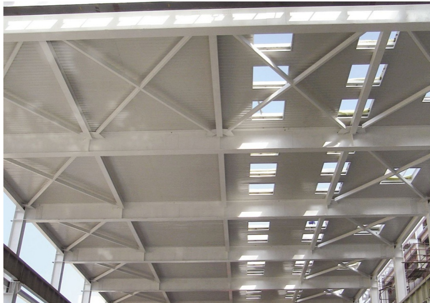
汽轮机厂房钢屋架及采光式压型钢板屋面
