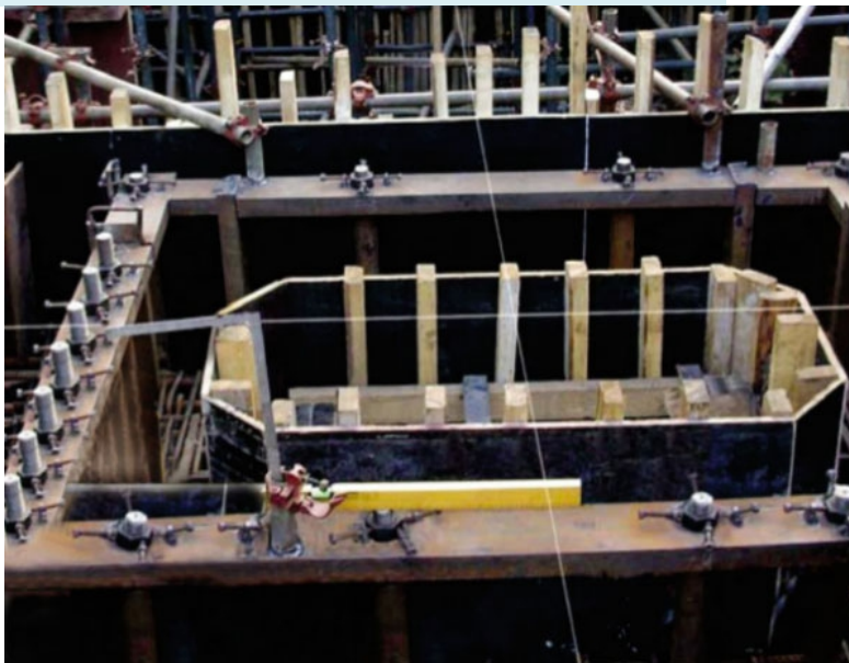
螺栓固定钢架定位工艺
