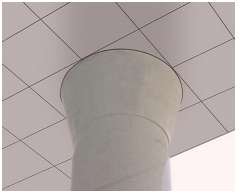
吊顶在顶棚和墙柱的连接处设置暗槽
