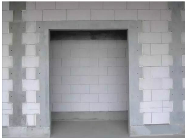
门洞口构造梁柱工艺
