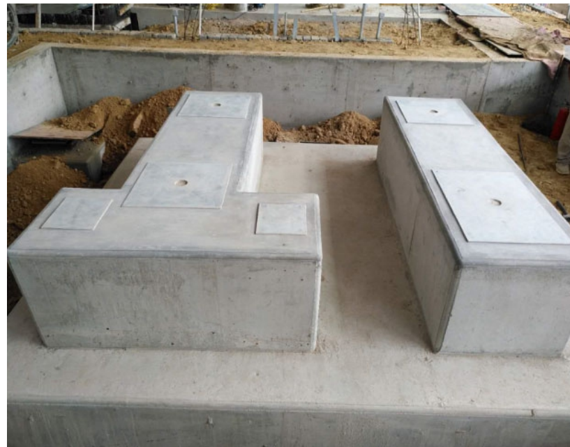
设备基础倒圆角（二）
