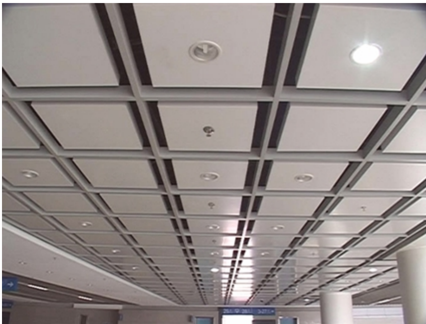
铝合金格栅明骨架吊顶方式
