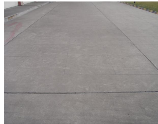
室外混凝土地坪分隔缝
