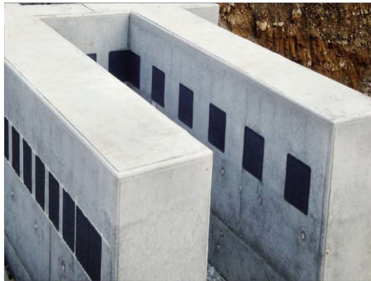
墙体埋件施工
