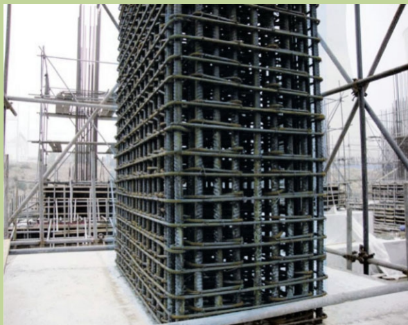
柱钢筋绑扎工艺
