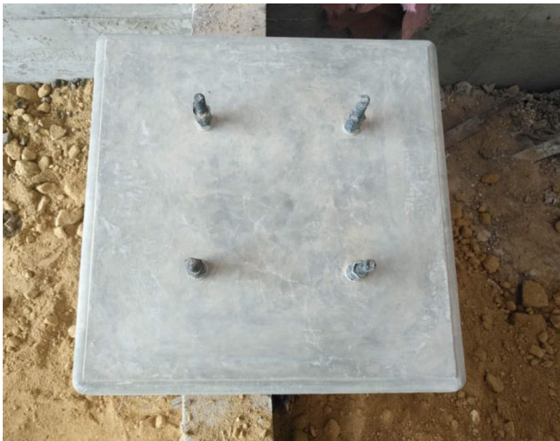
设备基础倒圆角（一）
