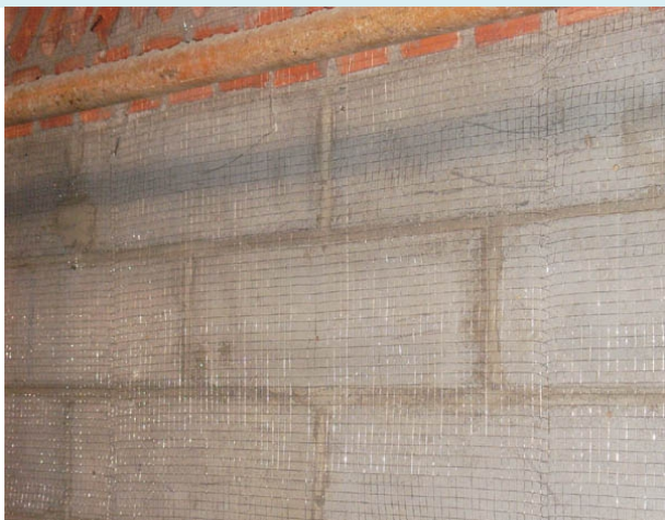
加气混凝土砌块墙面满张钢丝网防裂
