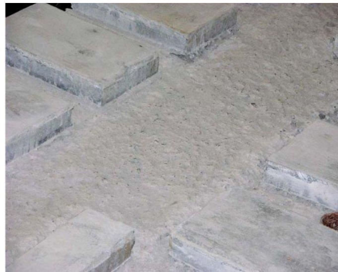
设备基础二次灌浆前凿毛处理
