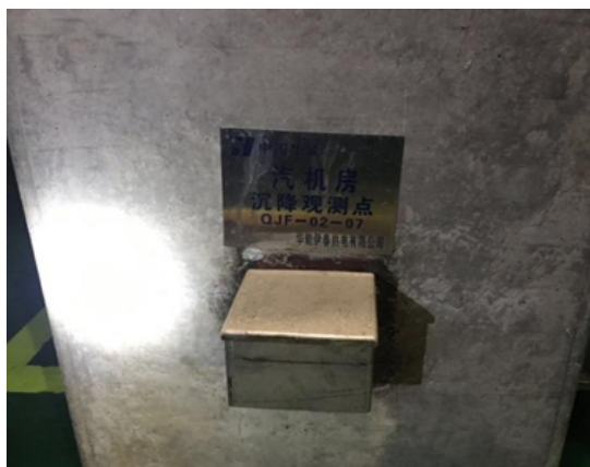
汽机厂房立柱沉降观测点保护盒
