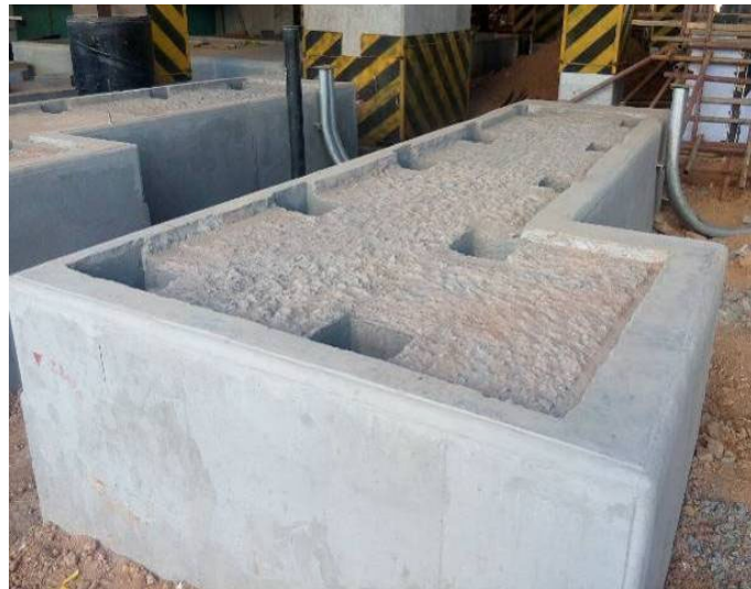
设备基础二次灌浆外沿施工工艺
