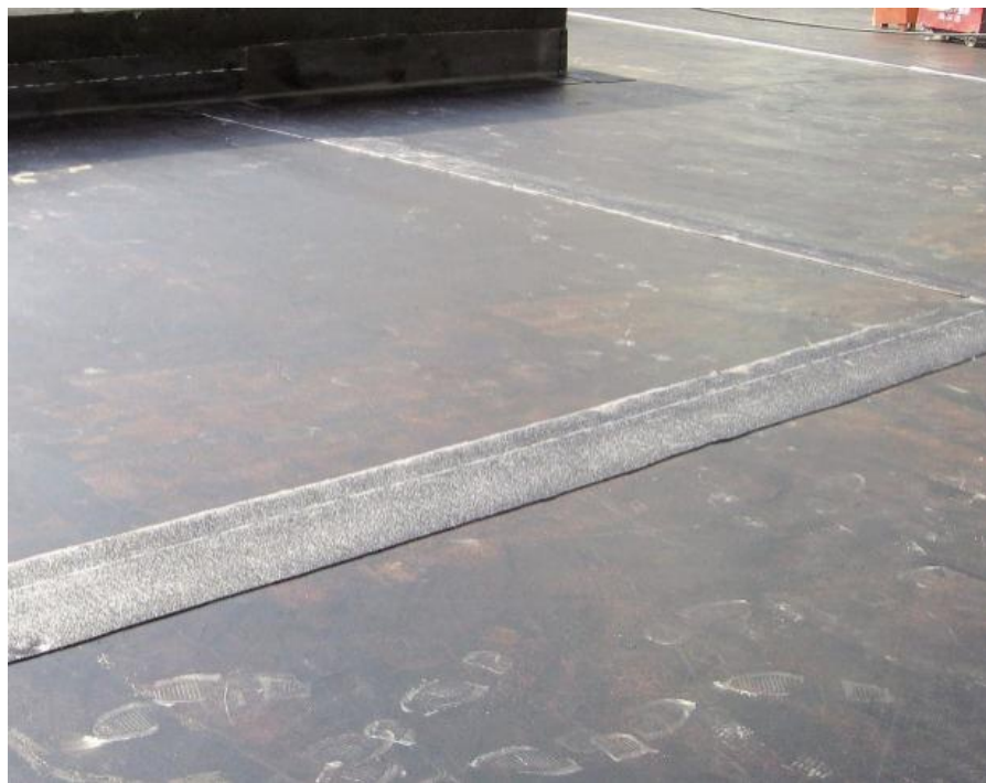
屋面卷材附加层施工工艺
