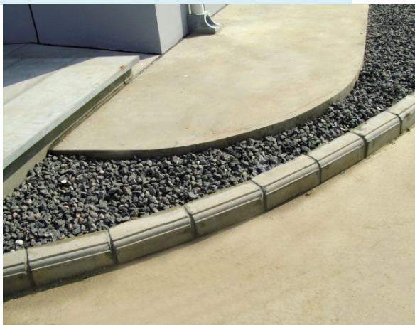
转角处路缘石施工工艺
