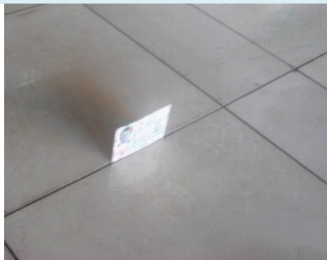
净缝施工法板缝间无水泥砂浆
