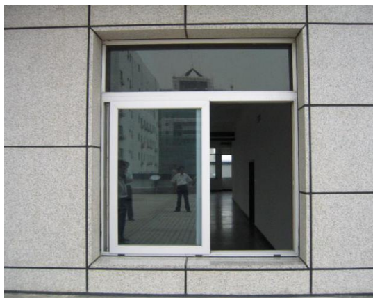
花岗岩饰面板拉缝法施工密封胶坎缝
