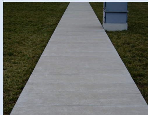
外压式盖板电缆沟道
