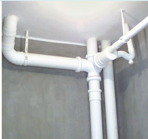
排水管道安装工艺
