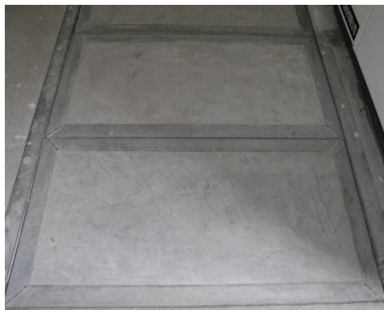
带角钢框的盖板压面效果
