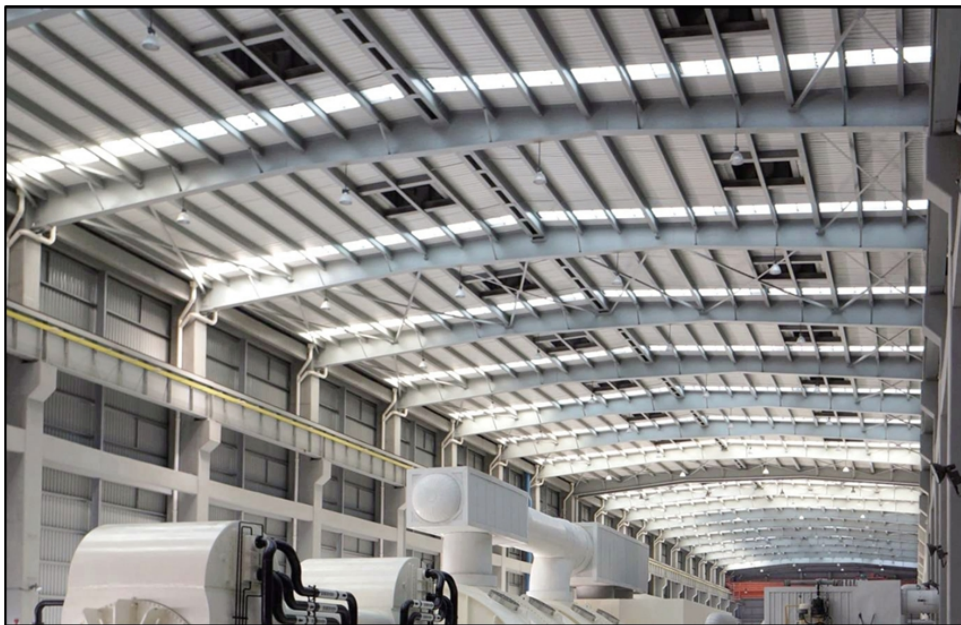
汽轮机厂房钢屋架及采光式压型钢板屋面
