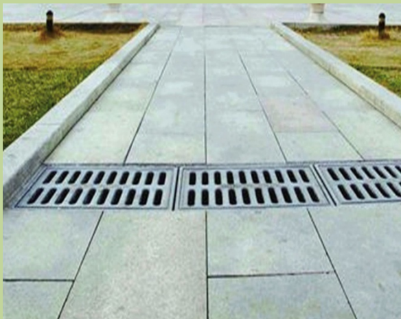
铸铁雨水篦子安装工艺
