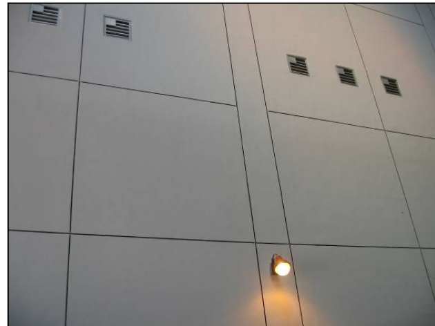
内墙面分隔缝工艺
