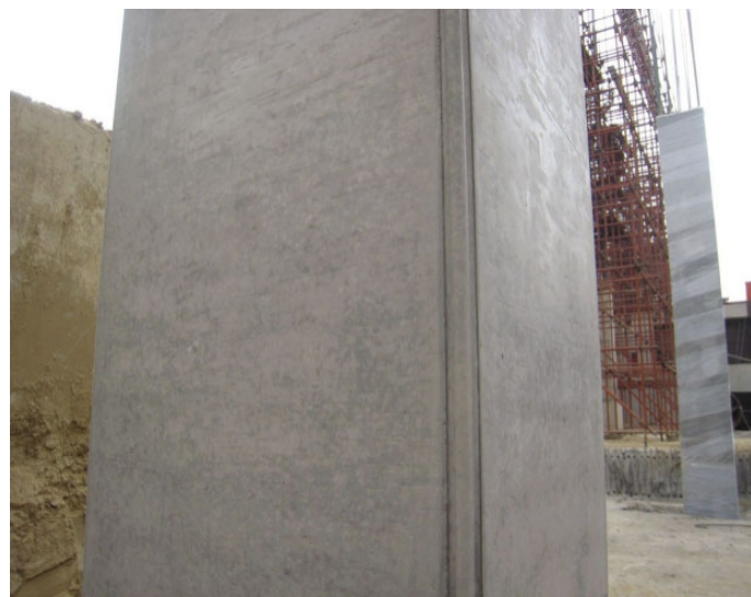
框架柱表面清水混凝土效果
