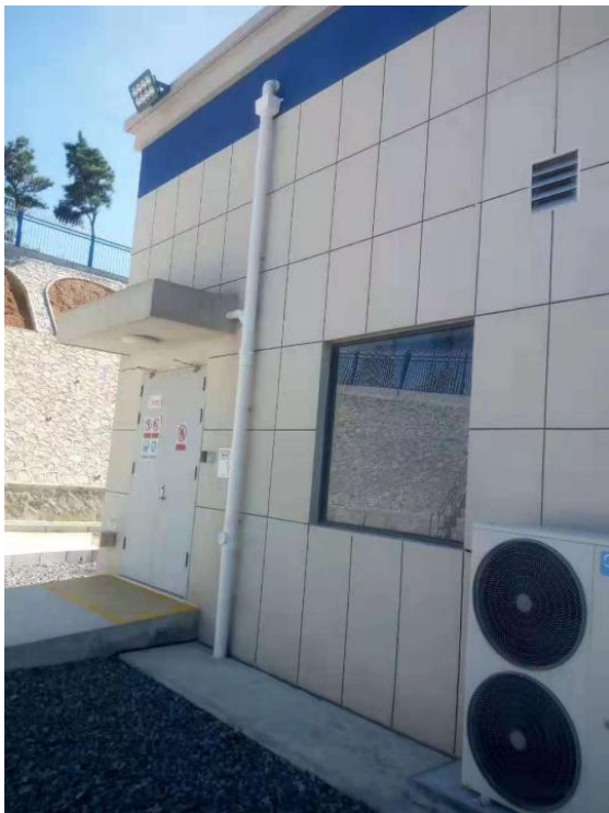
落水管直接连接地下排水沟
