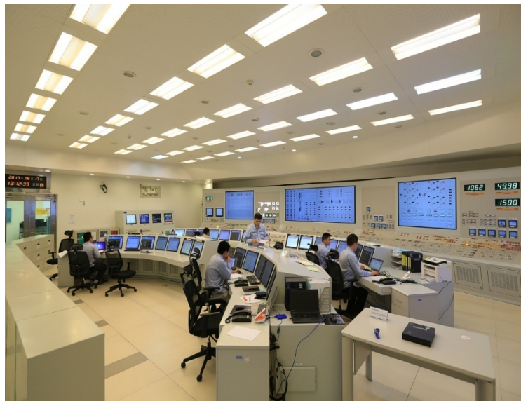
主控室筒灯格栅灯结合吊顶工艺
