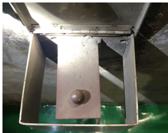
汽机厂房立柱沉降观测点
