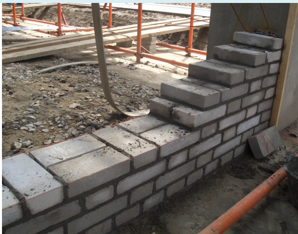
双面挂线控制砌体平整度
