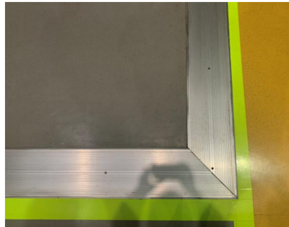
塑胶地面变形缝细部图
