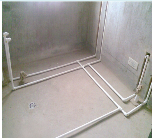
上水管道安装工艺
