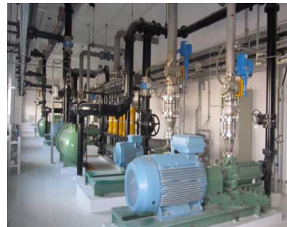
海淡厂房水泵油漆
