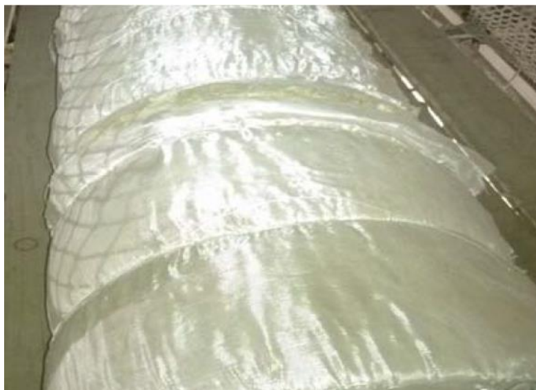
保温材料的铺设与绑扎
