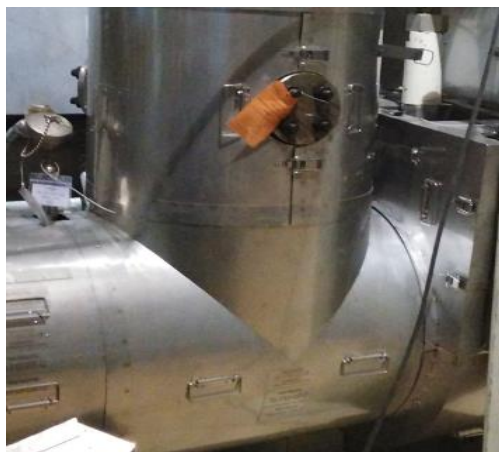
管道三通保温
