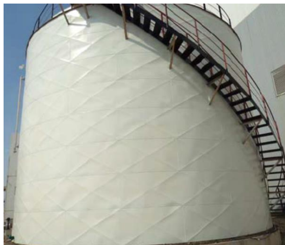
室外凝结水箱保温
