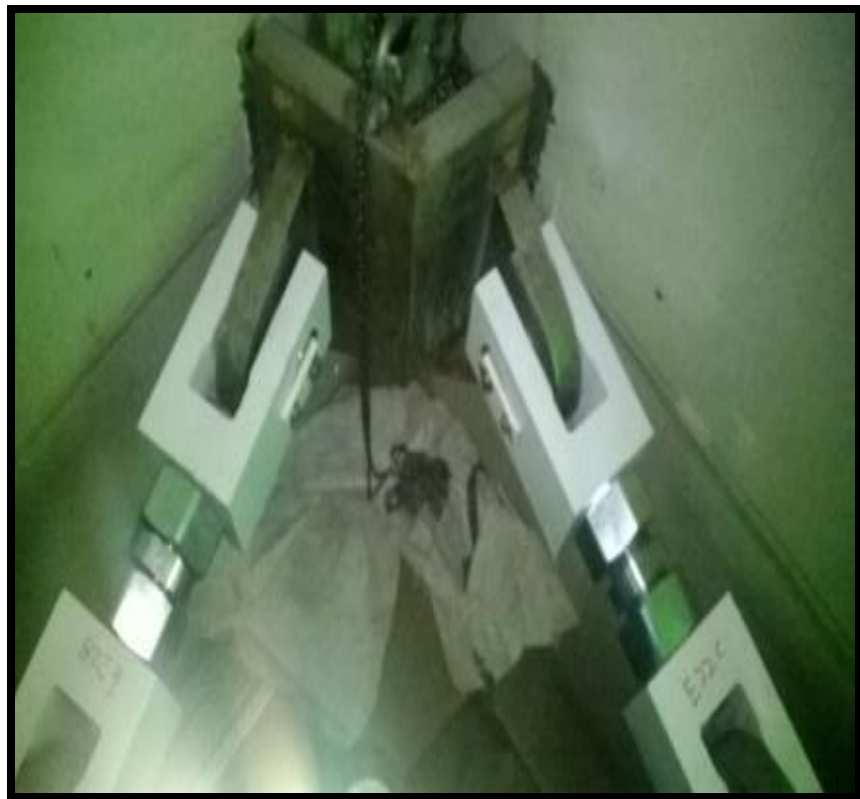
上部水平支撑安装
