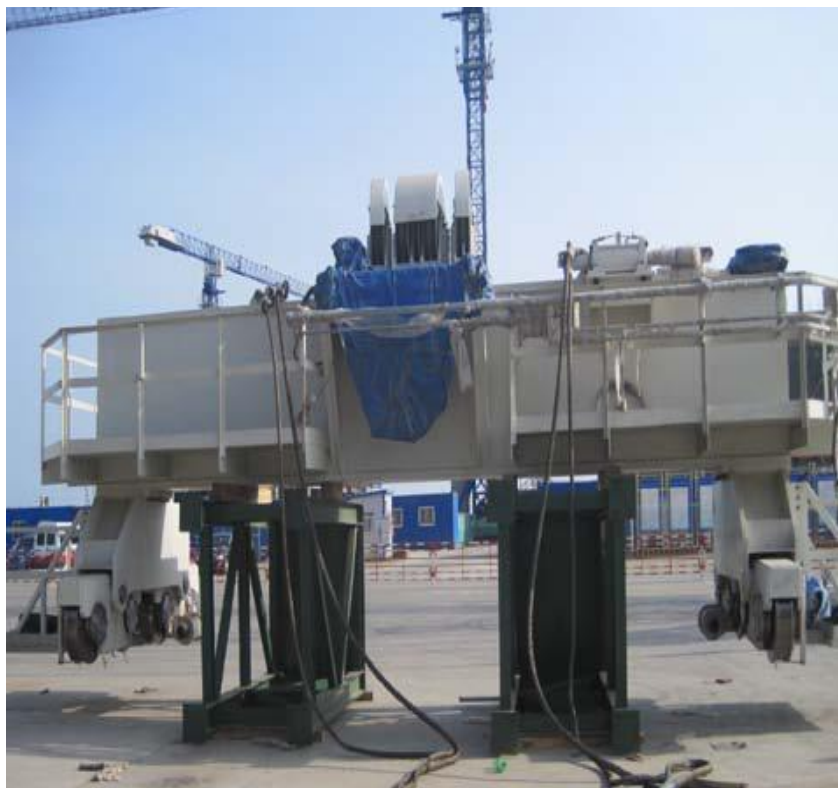
环吊小车安装
