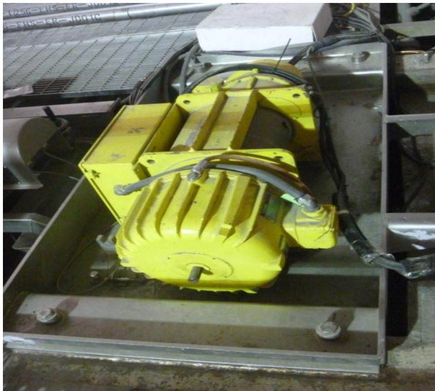
卷扬机组件安装
