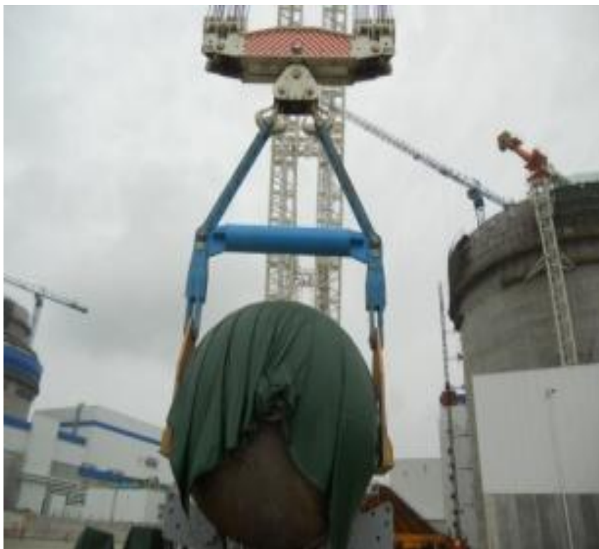
专用吊具的安装
