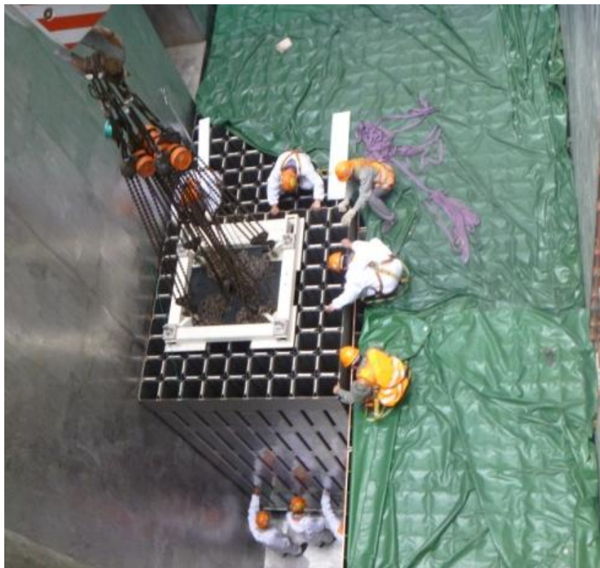
格架吊装安装
