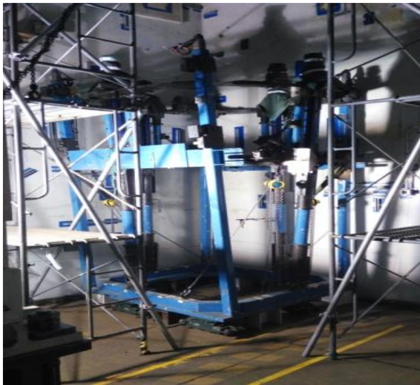
主泵小车安装
