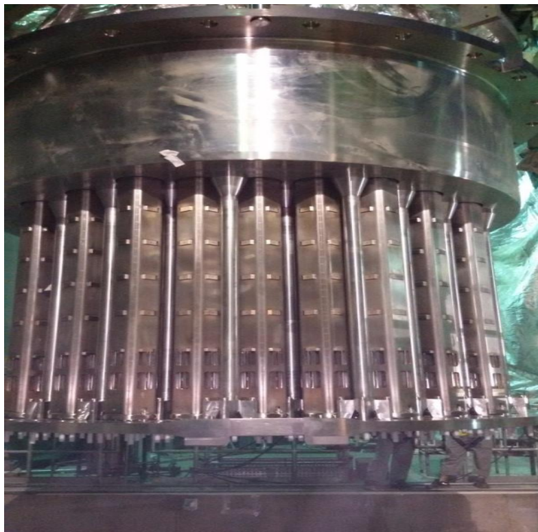
下部堆内构件组件第四次吊入RV
