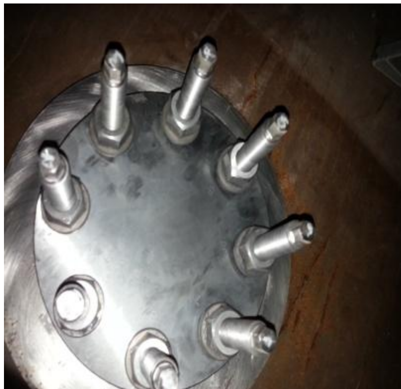
手孔、检查孔盖板安装
