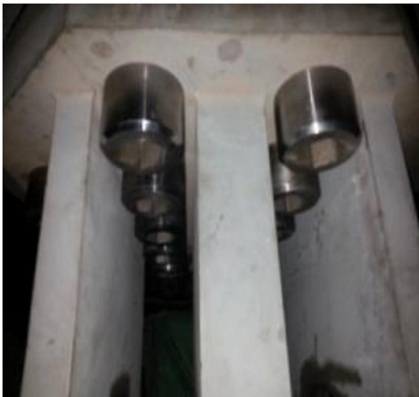
接合器与SG进行螺栓安装
