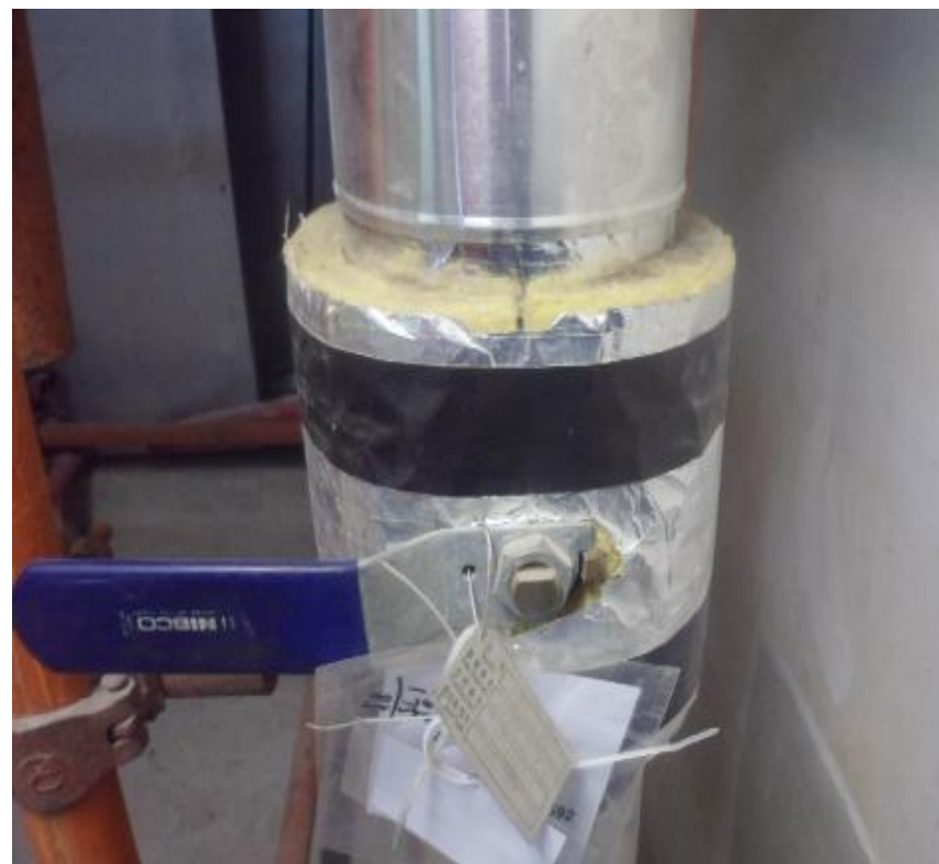
法兰的可拆式保温安装形式
