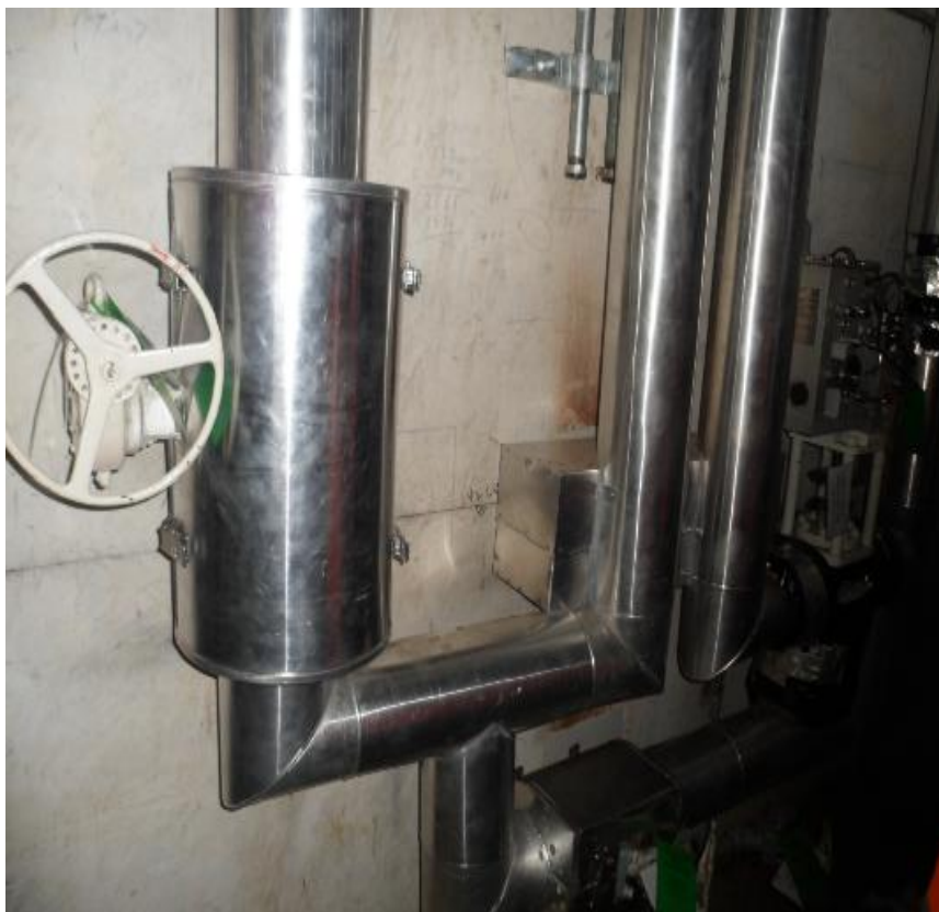
管道可拆式保温外护板制作安装
