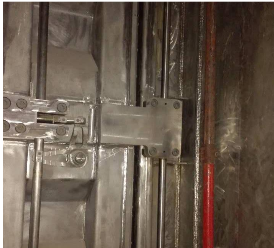
水闸门门体安装
