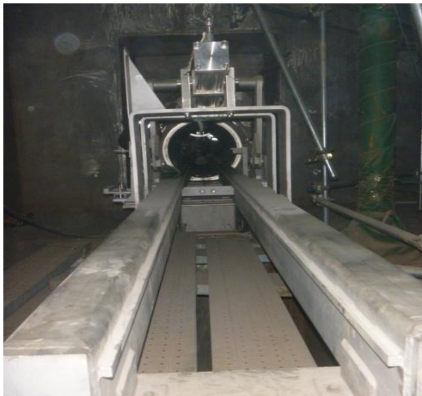
燃料运输系统轨道安装
