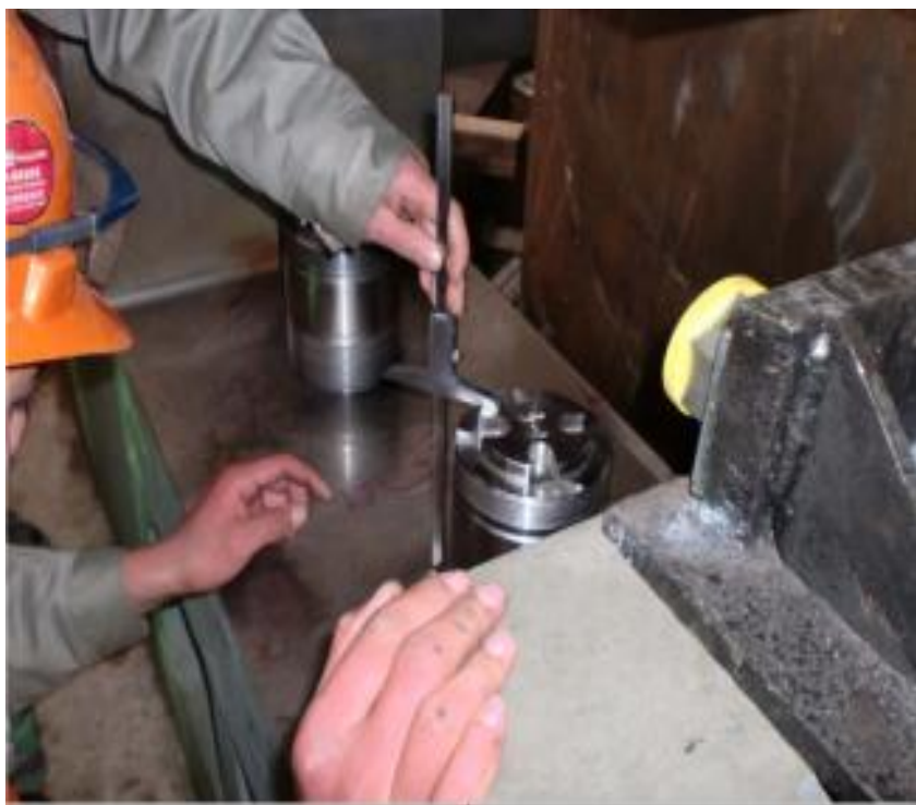
调平螺栓安装
