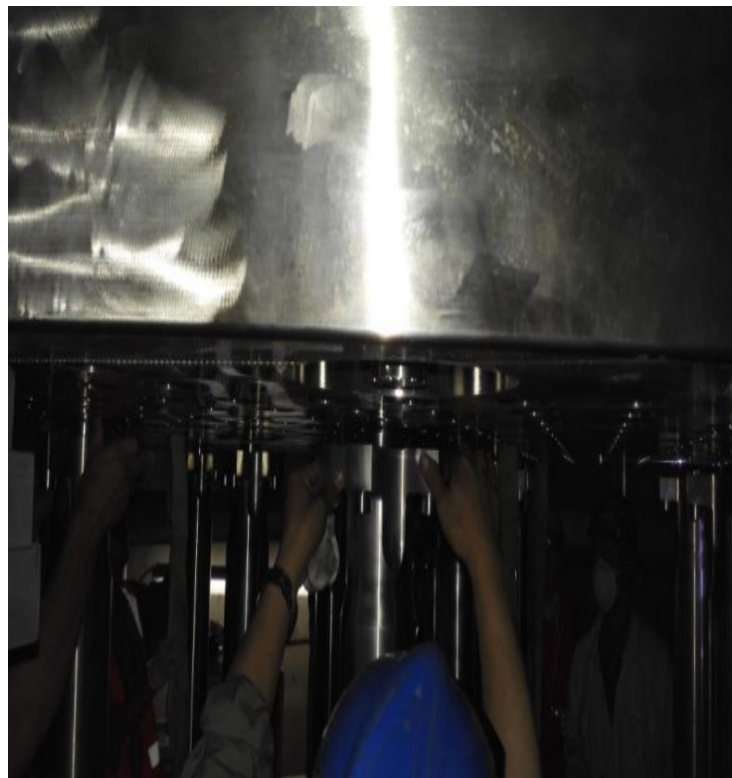
二次支撑结构最终焊接及装配
