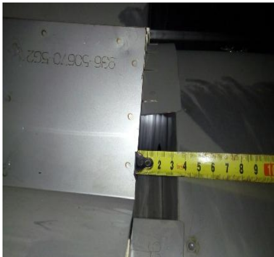
拼装保温块轴向间隙检查
