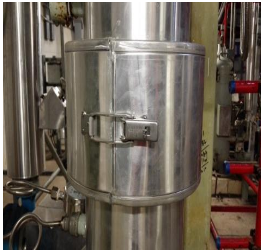
最终可拆式保温检查
