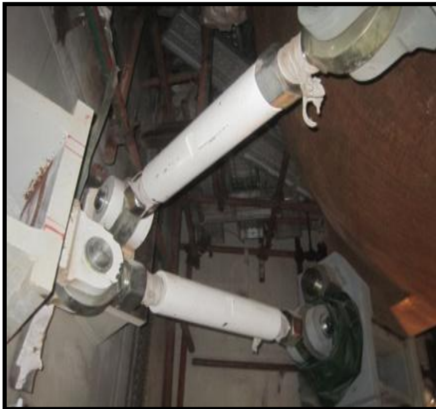
下部水平支撑安装
