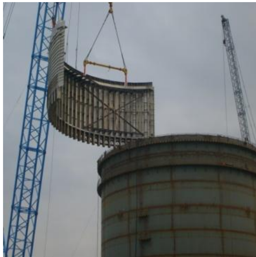
CV三环吊装
