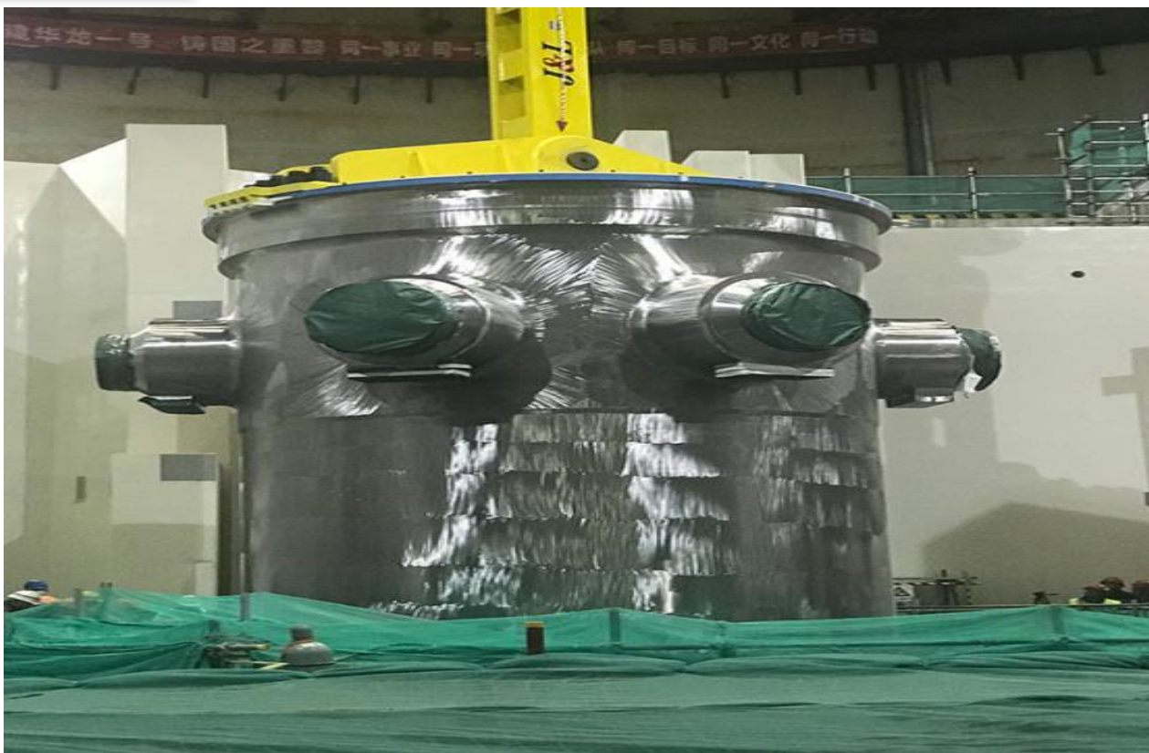
1.4 反应堆压力容器吊装就位
