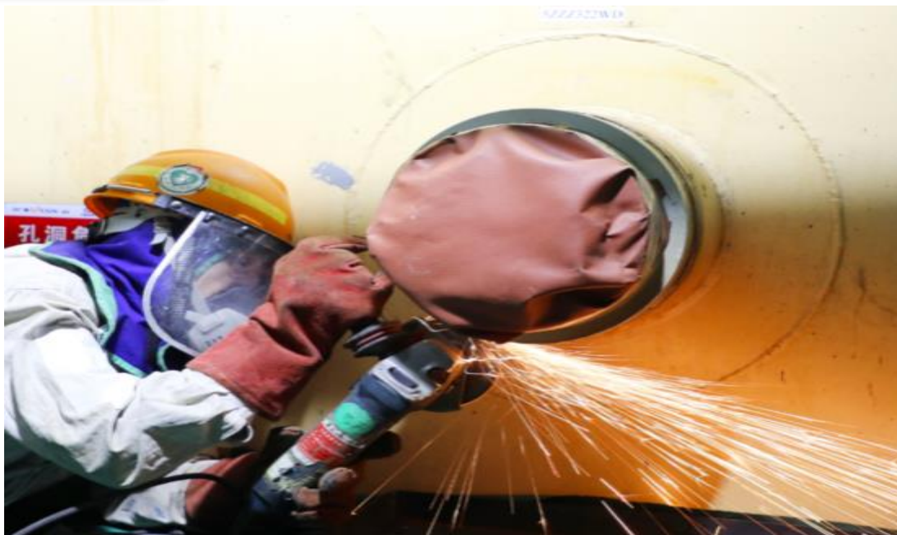
6.3 贯穿件坡口打磨
