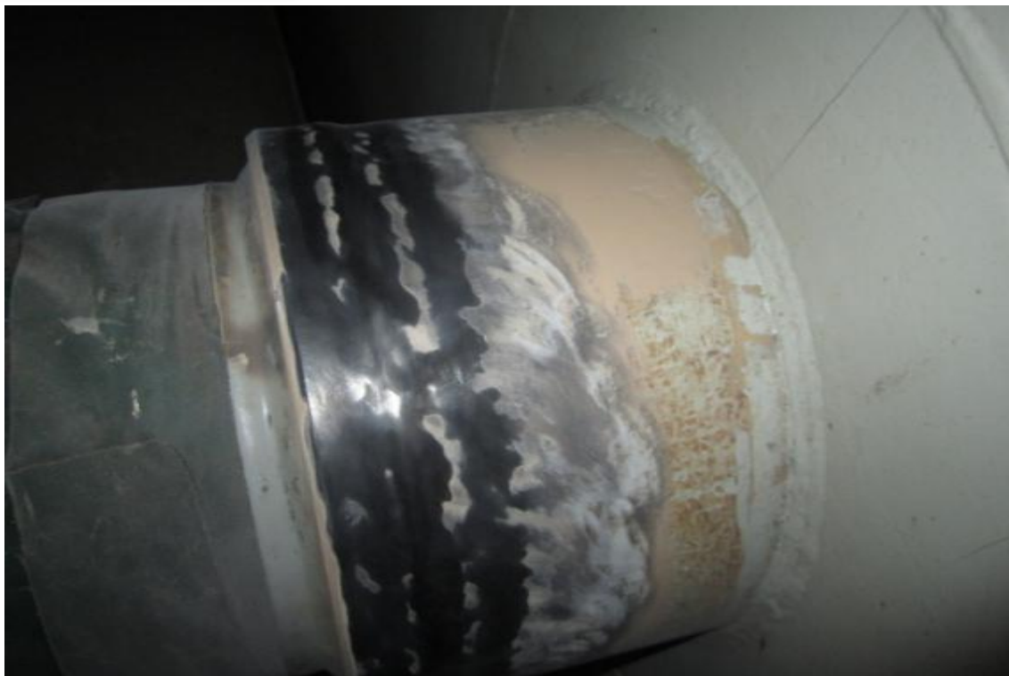
4.4 电气贯穿件焊接完成
