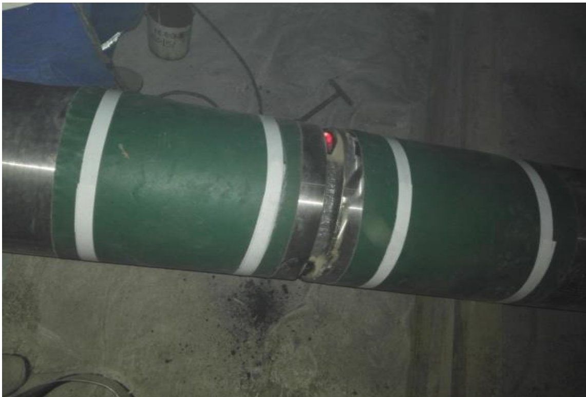
4.2 不锈钢大厚壁管层间焊接
