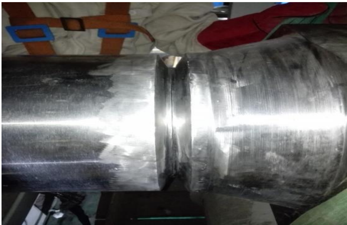
4.1 不锈钢大厚壁T型坡口组对
