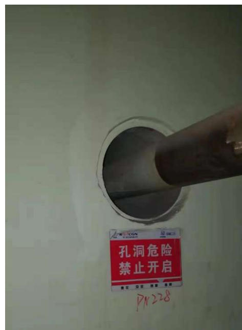
穿墙大套管现场照片
