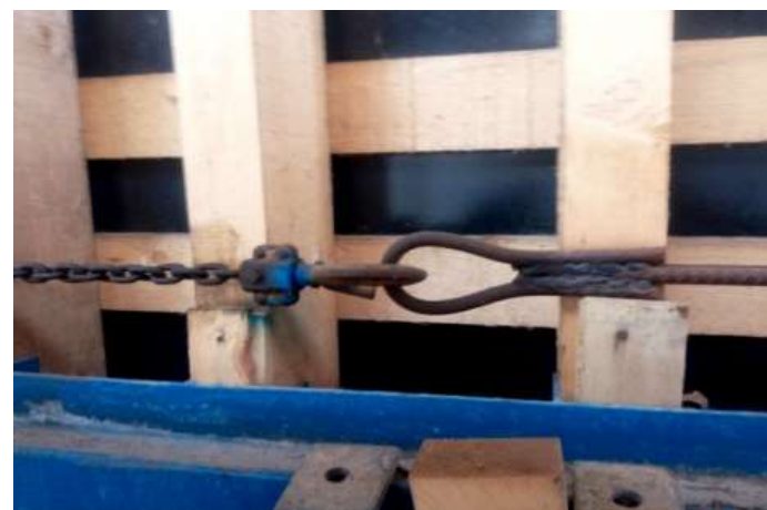
弧形模板套箍工装
