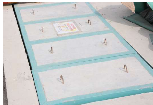
预制盖板现场安装效果
