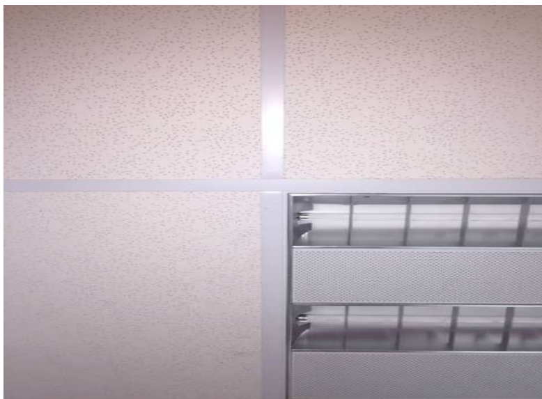
吊顶面板、灯具与压条组合效果
