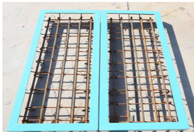
预制盖板钢筋施工效果
