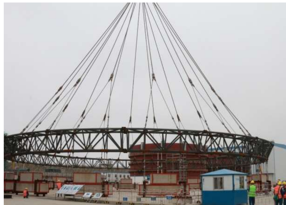
吊装工装荷载试验
