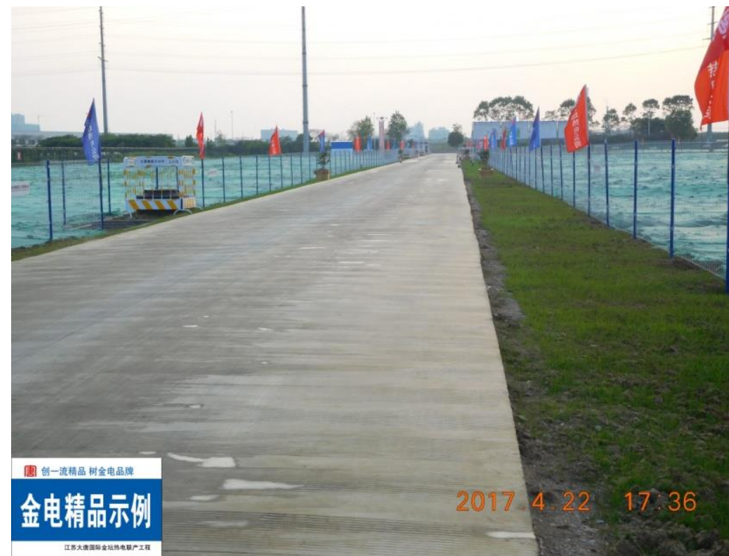
道路永临结合、绿化
