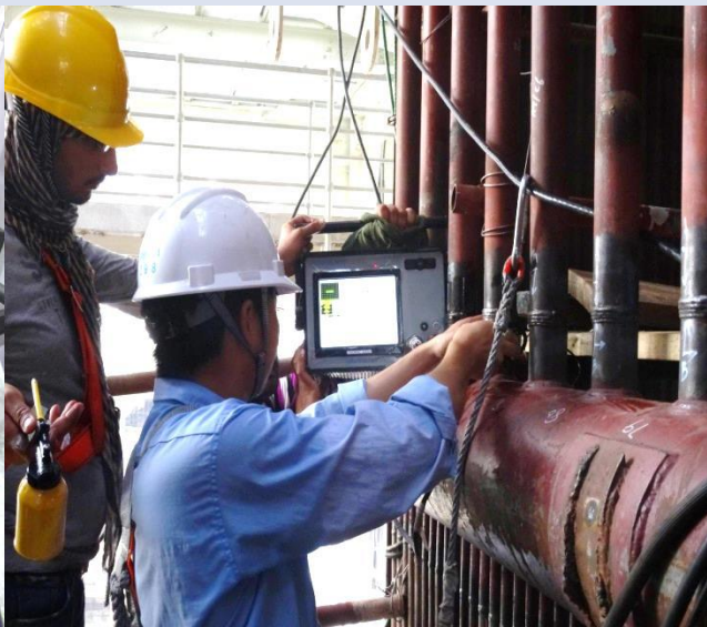
相控阵超声检测技术现场应用
