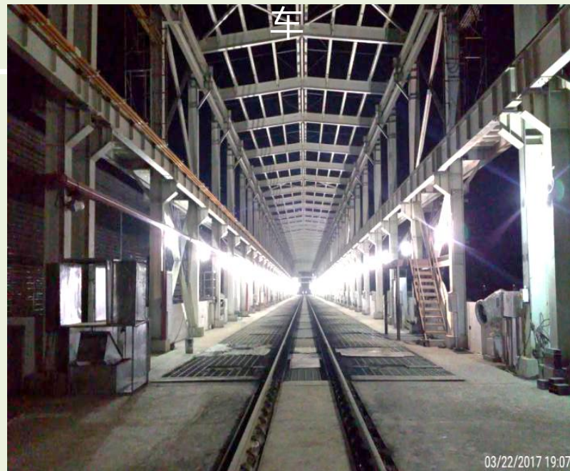
卸煤沟，可满足20节底开车同时卸
