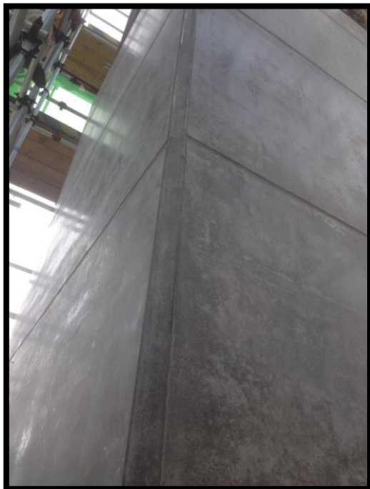
图 4 汽轮机基座框架柱清水混凝土实体
