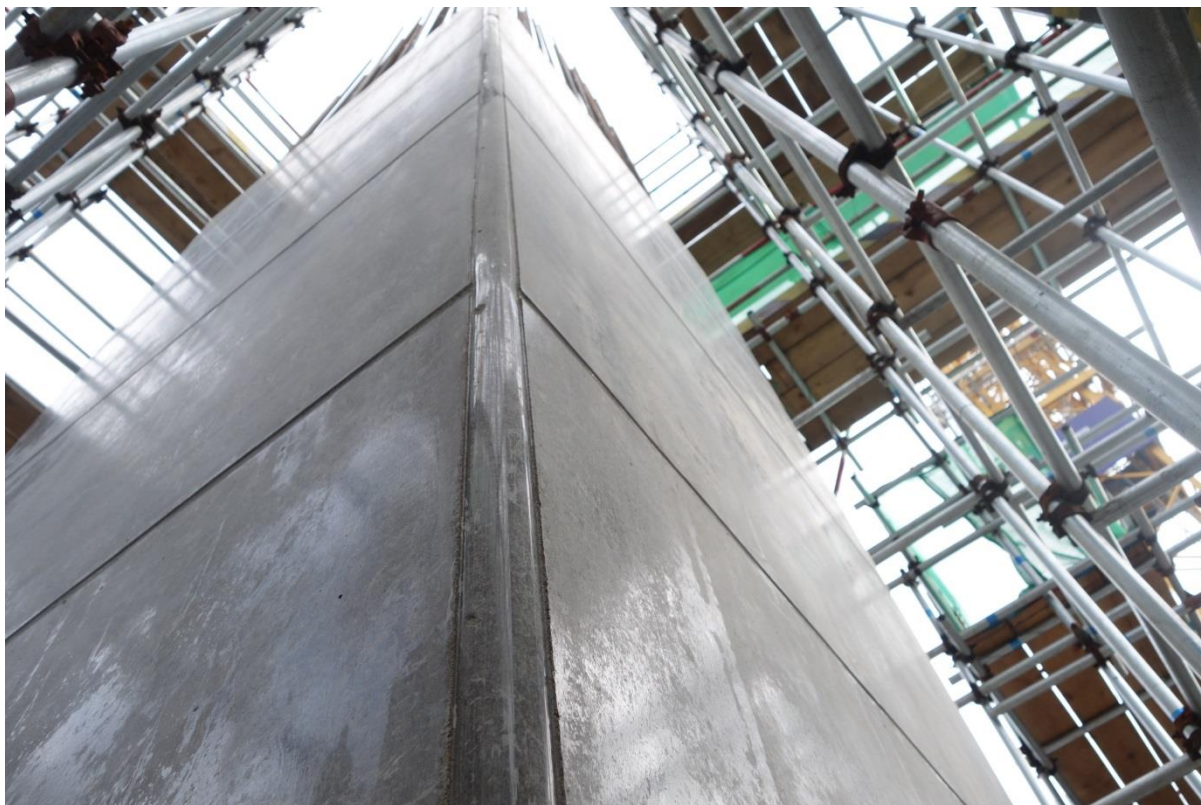
图 5 汽轮机基座框架柱清水混凝土实体
