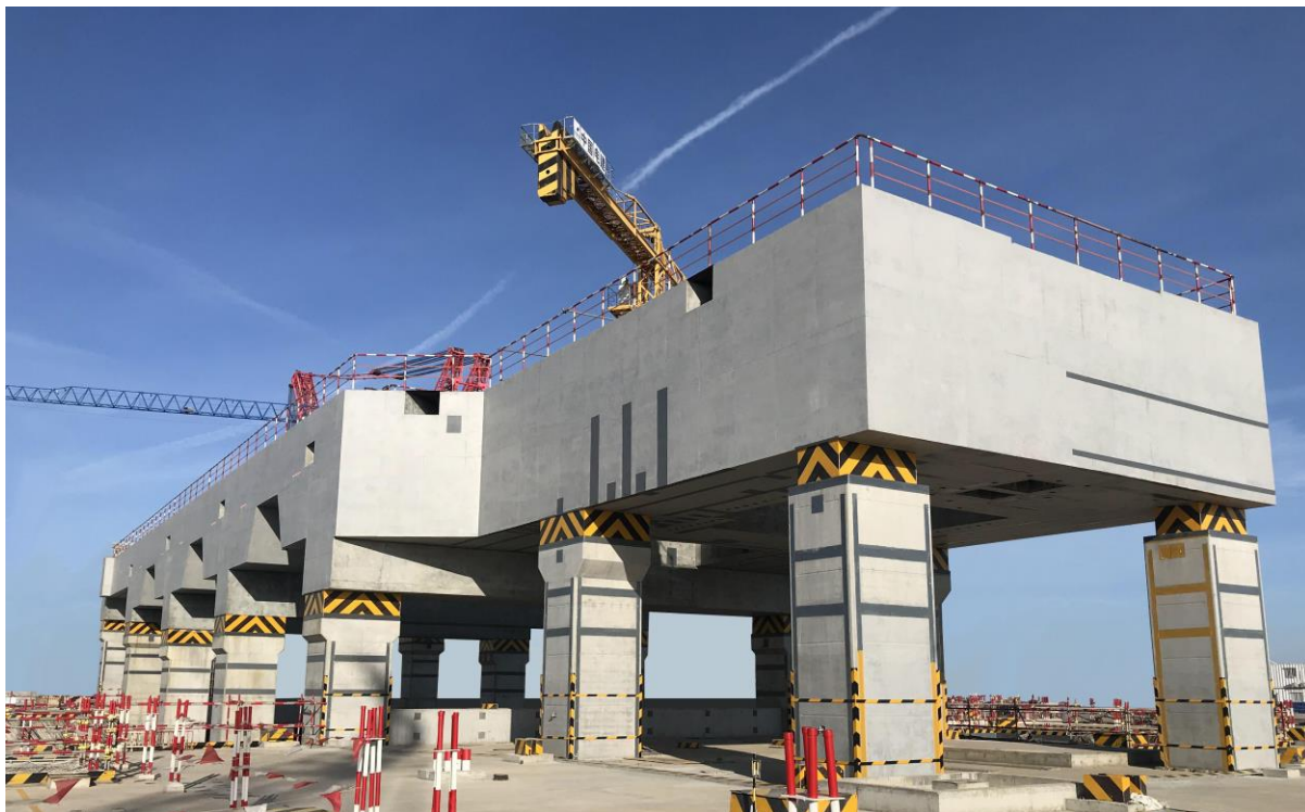
图 6 汽轮机基座台板清水混凝土实体
